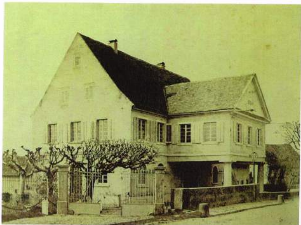
Der Dorfbach verläuft nach Unterquerung der Hauptstraße an der Villa Roth vorbei. Das Bachufer war von Quadern gesäumt. Foto etwa um 1900
