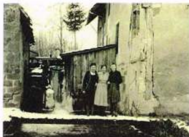
Auf der Brücke zwischen der Oberen Mühle und der abgerissenen Ölmühle: Von links Müllerstochter Margarethe Fünfschilling, Elsa Jacob, Lisbeth Bauer
