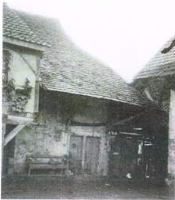
Im Hof der Niederen Mühle 1922
