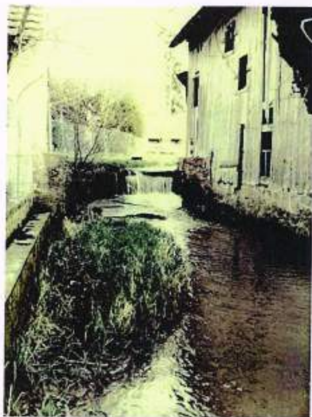
Mühlbach bei der Dröschli unterhalb des Absturzes, wo sich das Mühlrad der Niederen Mühle befand
